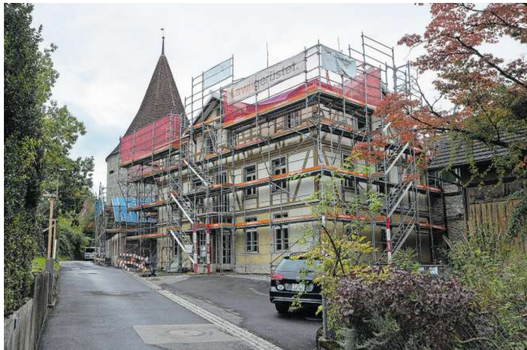
Schon in einigen Monaten sollen neun Wohnungen in den und sanierten Häusern am Knopfliweg 4 und 6 in Zug vermietet werden.
